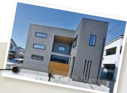
exterior 1:外観／黒のサイディングでシックな佇まい。窓の配置に統一感を持たせてよりシャープな印象に。
